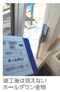
竣工後は見えないホールダウン金物
